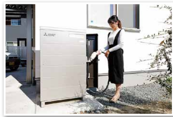
EV用パワーコンディショナー： 「SMART V2H」/約163万円 電気はすべてここを経由してから家庭やEV、電力会社へ。割とコンパクト
