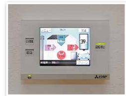
HEMS/約12万円 [SMART V2H]の操作パネルは屋内に。買電・売電の切り替えやEVへの充電、モードの切り替えなども簡単操作。
